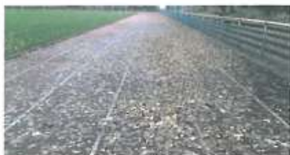
Príklad zlého stavu povrchu: Veľmi znečistený syntetický povrch Príklad dobrého stavu povrchu: Vyčistený syntetický povrch
