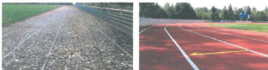
Príklad zlého stavu povrchu: Veľmi znečistený syntetický povrch Príklad dobrého stavu povrchu: Vyčistený syntetický povrch
