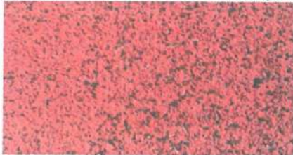
Príklad zlého stavu povrchu: Syntetický povrch pokrytý machom
