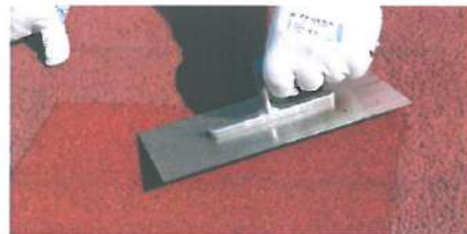
Opravený syntetický povrch
