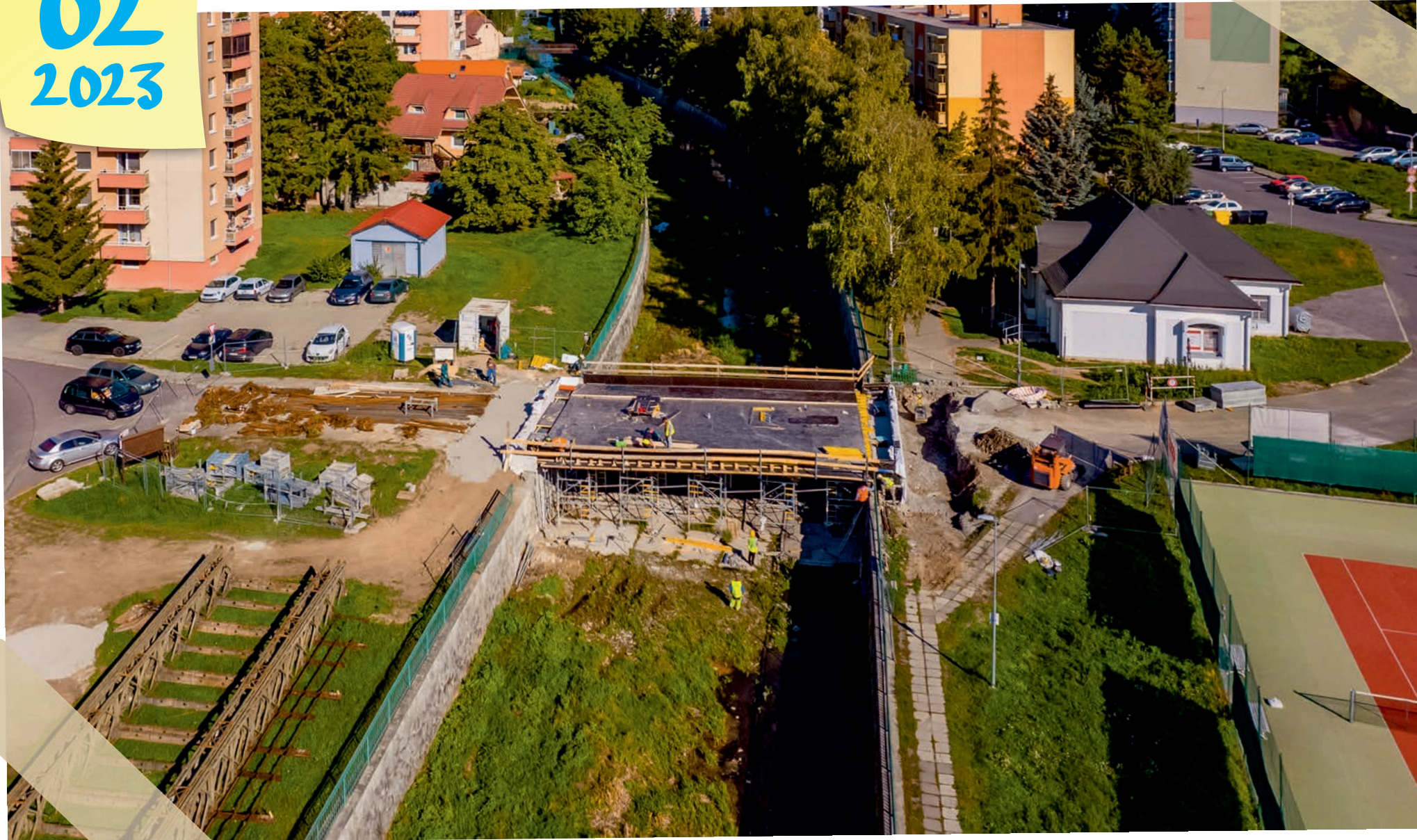
Príprava realizácie nového mosta nad Krupinicou v roku 2022
