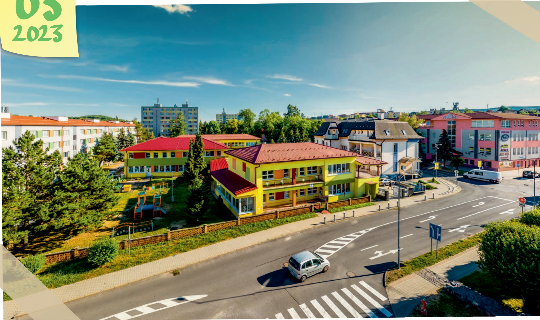
Materská škola na Malinovského ulici – rekonštrukcia a nadstavba v roku 2015
