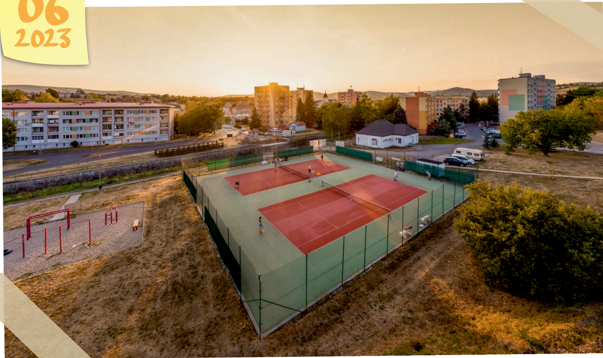
Tenisové kurty – komplexná rekonštrukcia v roku 2017
