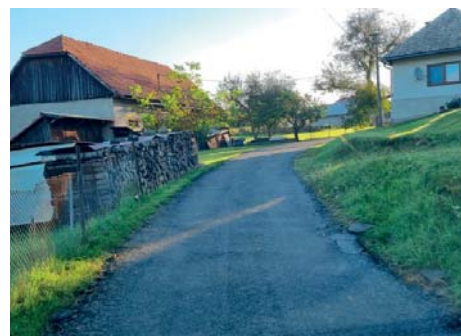
Oprava asfaltového chodníka na ulici E. M. Šoltésovej
