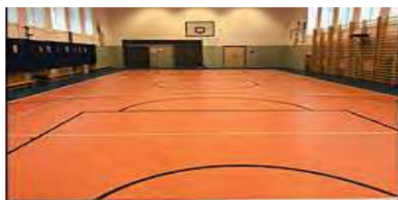
Rekonštrukcia podlahy v telocvični
