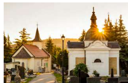
Oprava Hrobky rodiny Plachých
