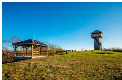
Vybudovanie prístrešku pri Vartovke
