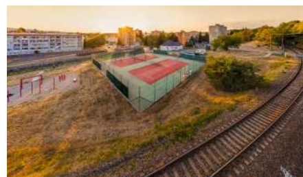
Stavebné úpravy plochy Street Workout
