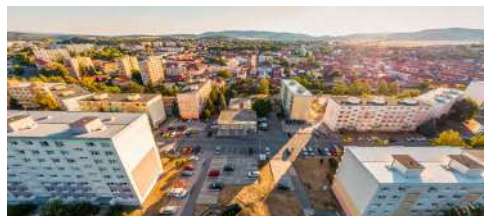
Výmena okien na obytnom dome Majerský rad
