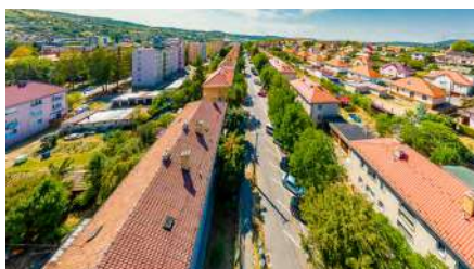
Rekonštrukcia ul. Fraňa Kráľa
