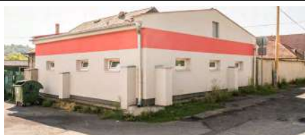
Rekonštrukcia garáže pre vozidlo DHZ
