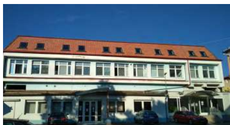
Oprava časti strechy budovy nemocnice
