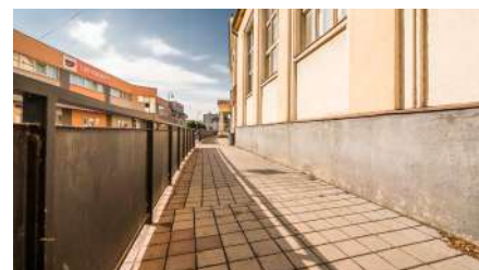
Rekonštrukcia časti chodníka pri ceste I/66
