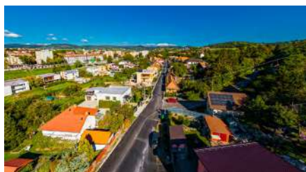
Rekonštrukcia ul. Dionýza Štúra
