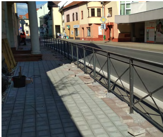
Oprava dlažby a montáž bariérovej chodníkovej zábrany
